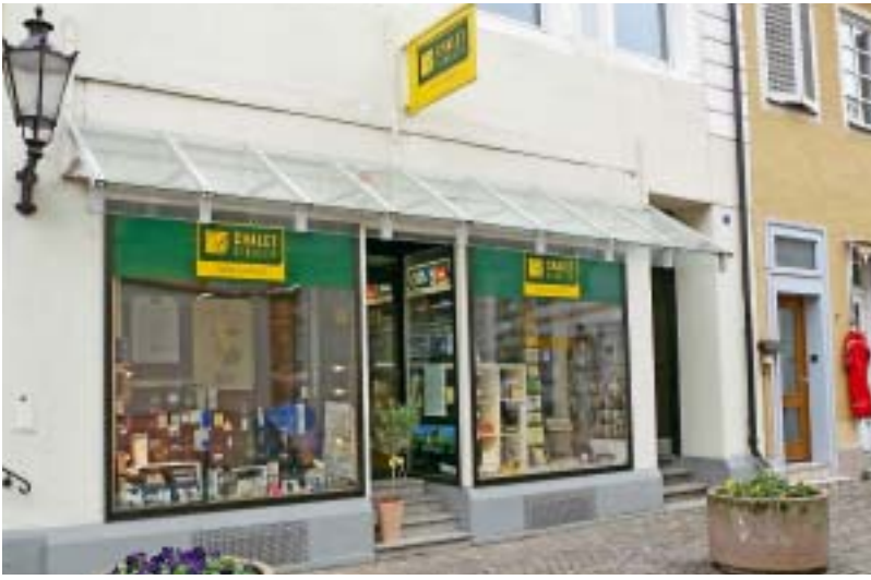
Beim „Chalet Dingler“ in Karlsruhe-Durlach machen zwei große Schaufenster Appetit auf mehr.
